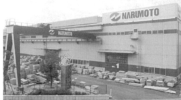
鳴本石材(株)の工場にて
